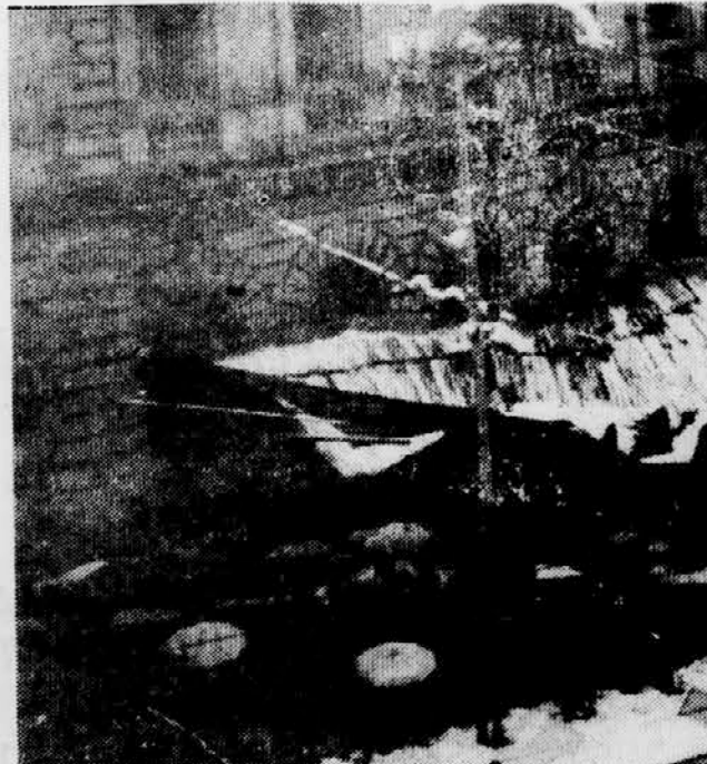
STREHA SE JE ZRUSILA NA LJUDI — Pred kavarno Evropa v Ljubljani se je včeraj ob 15.30 zrušila pločevinasta streha nad pločnikom, ker je bila prešibka, da bi lahko vzdržala udarac snežnega plazja, ki je padel s strehe kavarniškega poslopja. Izpod ruševin so potegnili 40-letno Marijo Volfo, doma iz Vge. Loke pri Blagovici, 17-letnega Rudija Zaleta in Ponja pri Pivki ter 35-letnega Antona Vrečarja iz Daljne vasi pri Domalah in jih prepeljali na ljubljansko polikliniko. Vsi trije so hujše ranjeni.
