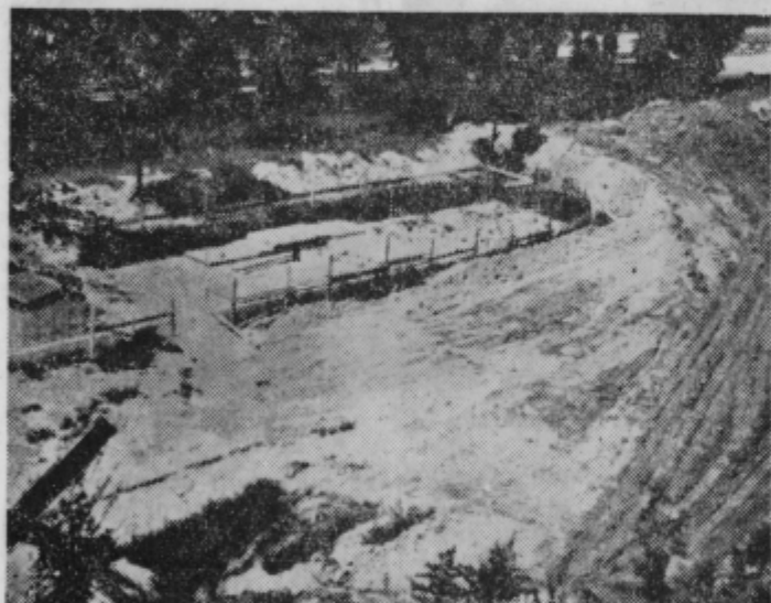
Priprave za gradnjo nove vinske kleti v Ormožu
