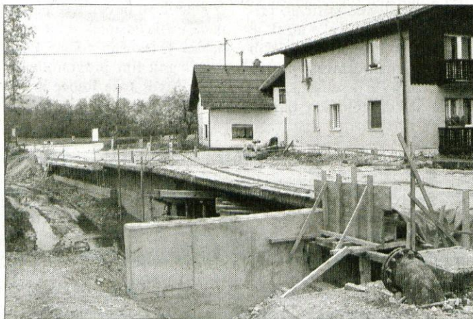
Gradnja novega mostu na 30. delovni dan 2. maja.
