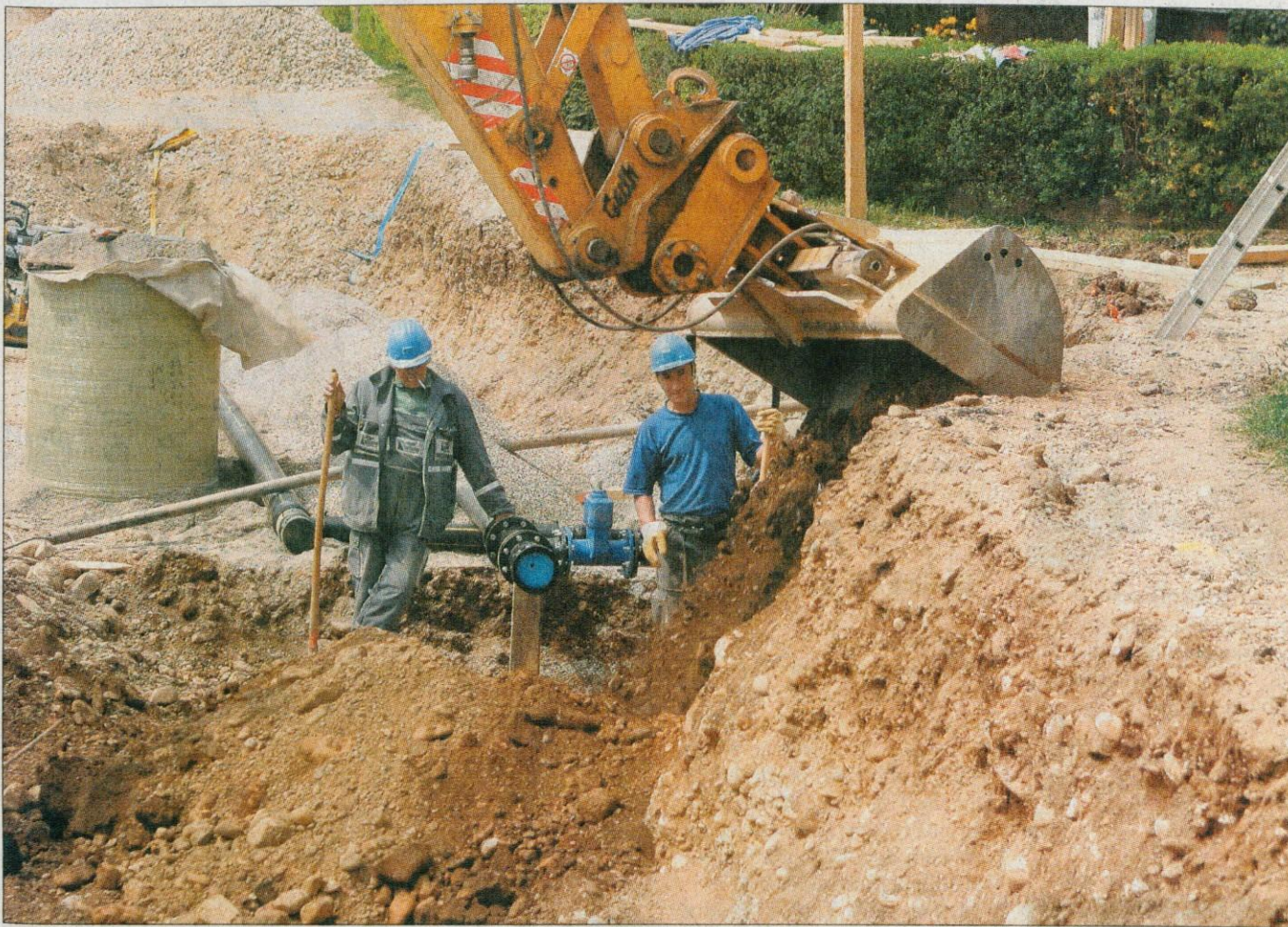
Gradnja kanalizacije v Britofu. Foto: Tina Dokl
