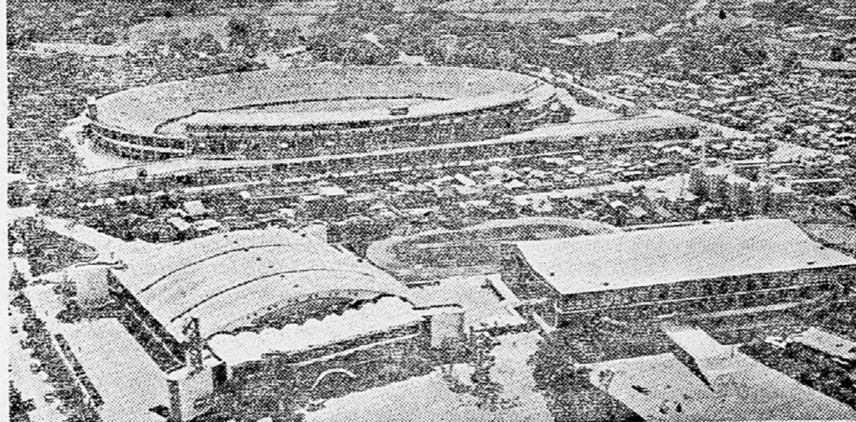
Za tretje vsezijske igre so v Tokiju zgradili velikanski stadion (v ozadju), ki more sprejeti 70.000 gledalcev. Na levi je telovadnica, desno spodaj pokrit plavalni bazen, nad njim pa bazen na prostem.
