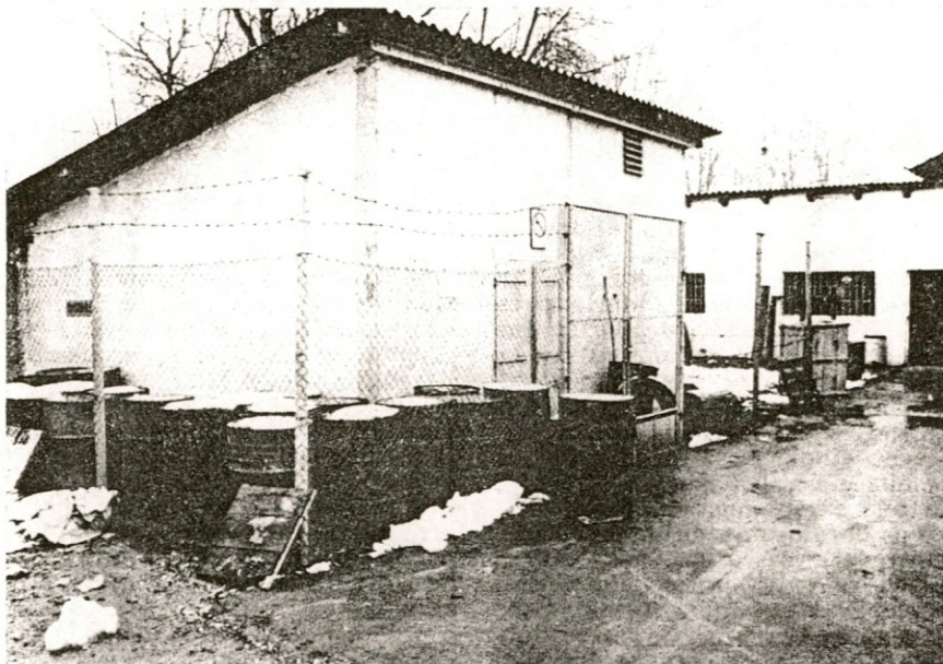
Skladišče bencina — ena od potencialnih nevarnosti za nastanek požara
