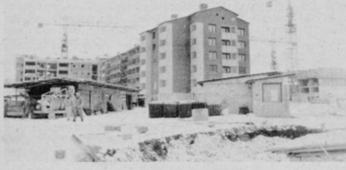
V objektih B-6 in B-7 bo letos vseljivih 225 stanovanj.
