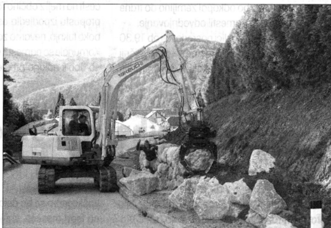
Delavci pri izdelavi škarpe, ki bo onemogočila plazenje zemljišča nad pločnikom (foto: Benjamin Kanjir)
