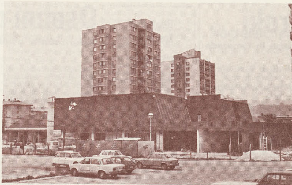
Blagovnica v Novi vasi je takorekoč že končana. Kmalu bo mogoče začeti z montažo potrebne opreme.
