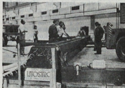
Mostno dvigalo še na tleh
