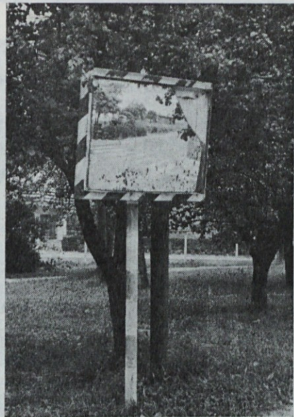
Razbito zrcalo na cestnem križišču v Preserjah
