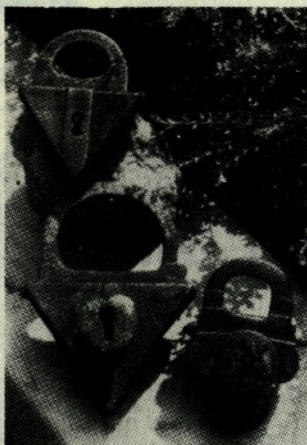
Avstrijska oziroma južno-nemška ključavnica iz 16. in 17. stoletja. Značilno za takratno dobo je masivna, kovana izvedba in trikotna oblika.
