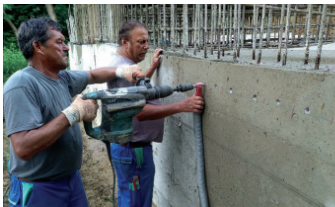
Slika 21 • Vrtanje lukenj za sidrno armaturo.
