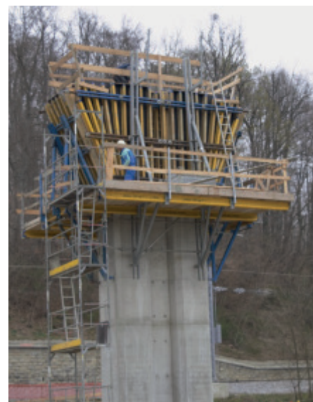
Slika 16 • Opaž razširjenega zgornjega dela stebra.
