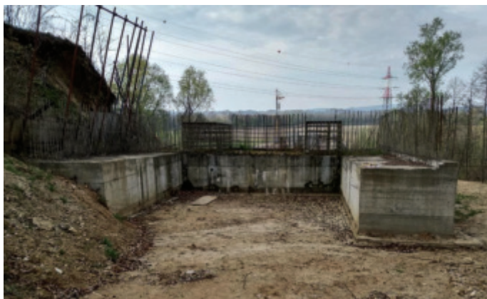
Slika 19 • Delno zasut opornik v osi 7.
