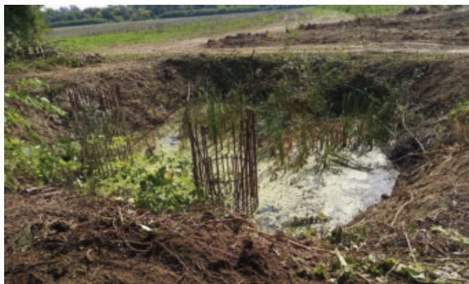
Slika 1 • Piloti vmesnih podpor septembra 2018.
