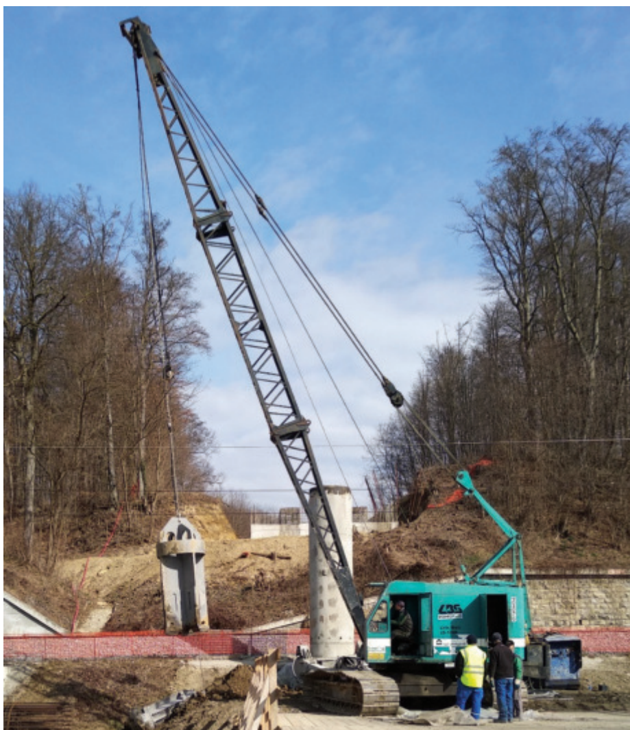
Slika 11 • Izvedba pilotov Benotto v osi 6.
