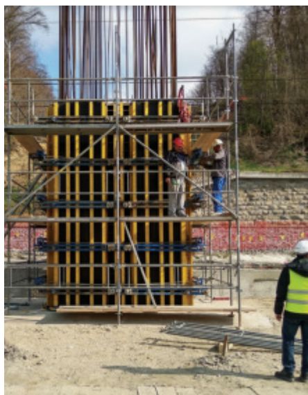
Slika 14 • Opaž spodnjega dela stebra.
