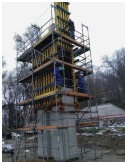
Slika 15 • Opaž vmesnega dela stebra.
