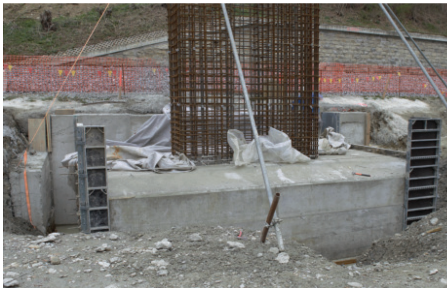
Slika 13 • Temeljna blazina v osi 6.
