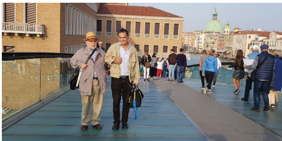
Slika 6 in 7 • Stekleno površino so morali zaradi številnih zdrsov pešcev popeskati in zato steklo ni več prozorno. (Foto: G. Humar).
