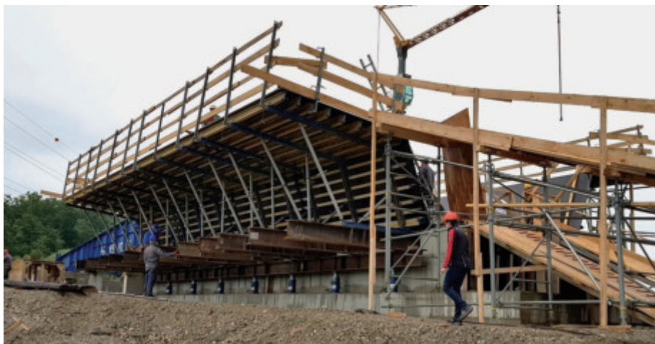
Slika 25 • Pogled na končano delavnico za narivanje.
