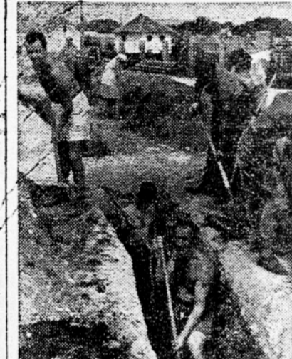
I. brigada SNG koplje jarke za vodovodne cevi pri klavnici
