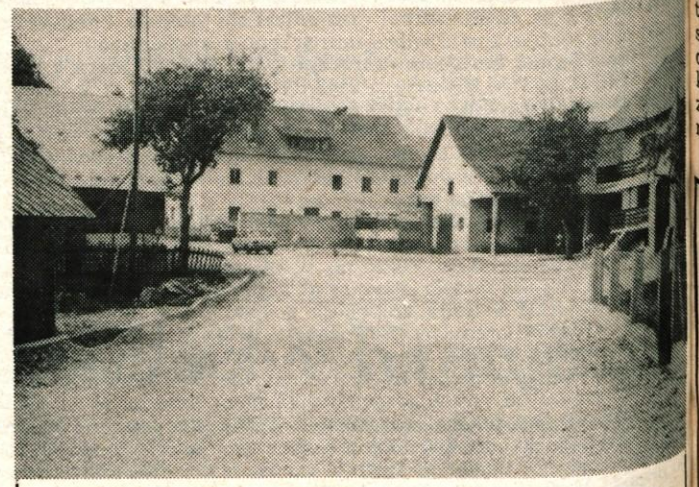
Pred dokončno ureditvijo — Med pomembnejšimi odseki, ki so bili letos v programu cestne komunalne skupnosti Kranj, je vsekakor cesta Hrastje — Trboje. Že lani začeta dela so se letos nadaljevala na dveh odsekih in sicer v Trbojah in v Hrastju. Tako kot v Trbojah, kjer od šole do križišča sredi vasi gradijo pločnik, tudi v Hrastju z deli končujejo. — A. Z.
