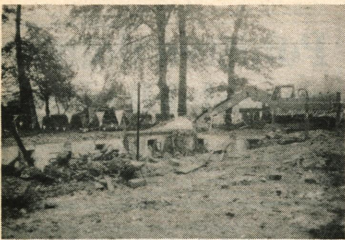
Škofja Loka, 26. oktobra — Par opek je vse, kar je ostalo od enega izmed dveh blokov v Frankovem naselju. Prejšnji teden so porušili star blok, kjer je bil včasih samski dom Jelovice. Na istem mestu bodo že novembra začeli graditi nov blok s tridesetimi stanovanji, v katerega se bodo stanovanjci lahko vselili že drugo leto. Nato bodo podrlji še sosednji blok in na njegovem mestu zgradili petdeset stanovanj ter poslovne prostore. — Foto: V. Stanovnik
