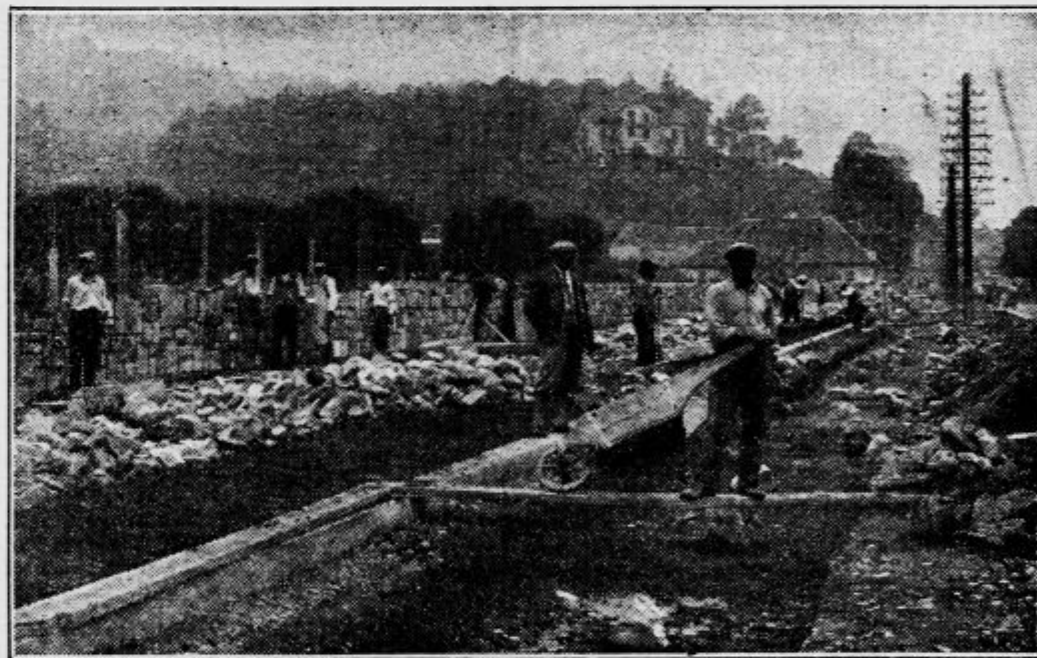
Pri delu na tramvajski progi v šiški.
