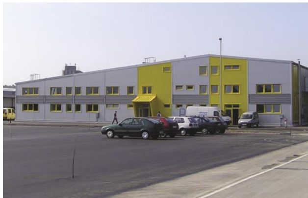
Slika 4: Tovarne hale škrobnih modifikantov (del nekdanje Kemične tovarne Domžale) v novih prostorih na Količevem, ki omogočajo sodobno in racionalnejšo proizvodnjo (foto: Simon Kušar).
