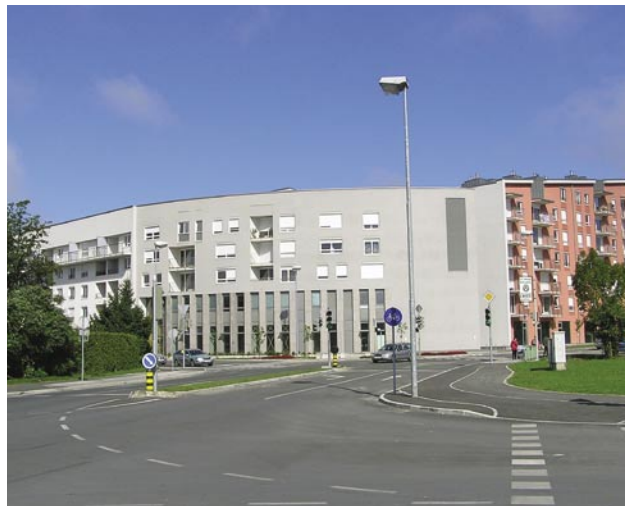
Slika 6: Na mestu nekdanjega Toka (proizvodna lokacija Toko 2) je že zgrajena poslovno-stanovanjska soseska Krizant, ki predstavlja zametek vogala pri vstopu v mesto. V času gradnje je velik plakat na križišču vabil k nakupu za četrtno cenejših stanovanj in poslovnih prostorov kot v Ljubljani (foto: Simon Kušar).
