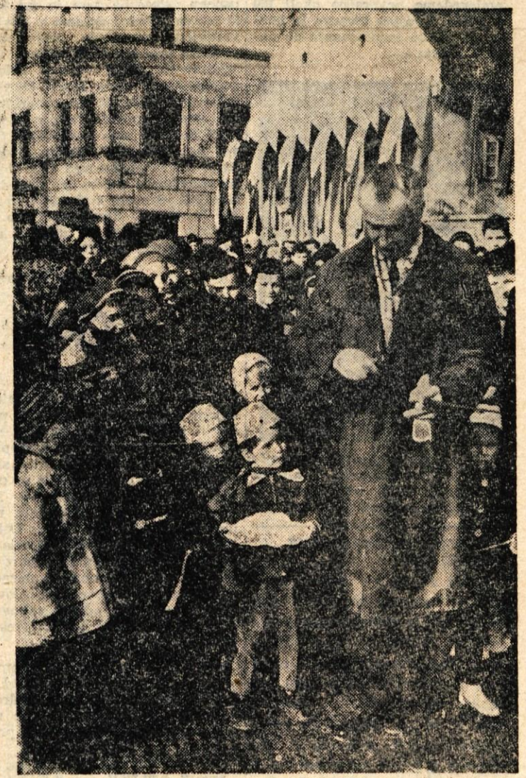
Predsednik Sveta za gradbene in komunalne zadeve Mile Vozel je prerezal trak in s tem izročil mostu prometu
