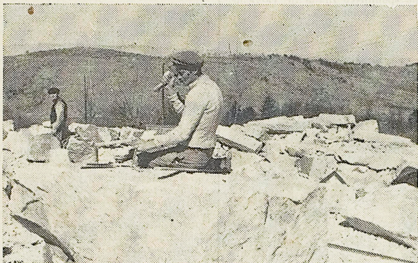
Blok marmorja »Repna« pri obdelavi v kamnolomu v Vrhoveljah
