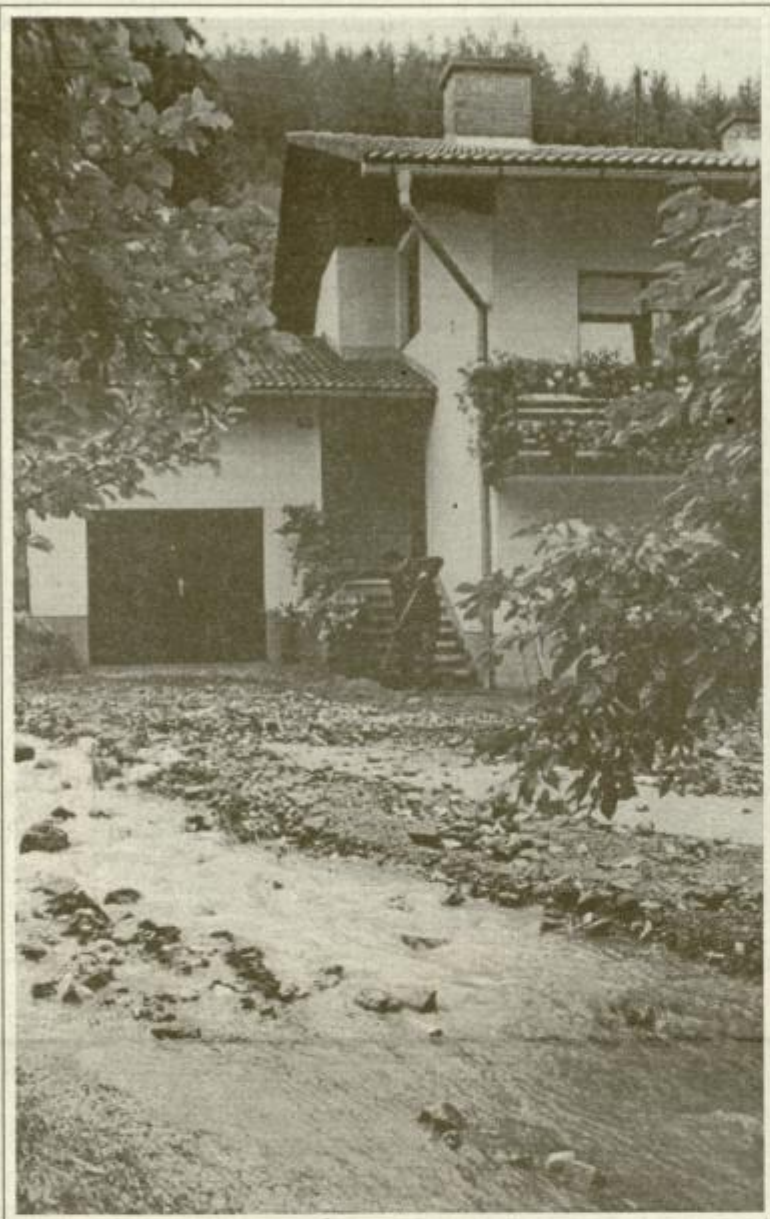
Voda je na območju Vitanja odnesla tri manjše mostove, poplavlila kleti osmih stanovanjskih hiš, uničevala ceste, brežine...
