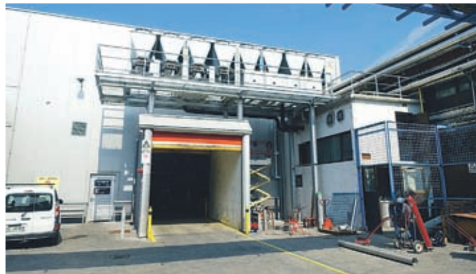
Energetske sisteme v celoti posodobljajo, zastarele cevi pa zamenjujejo z inox izvedbo.
