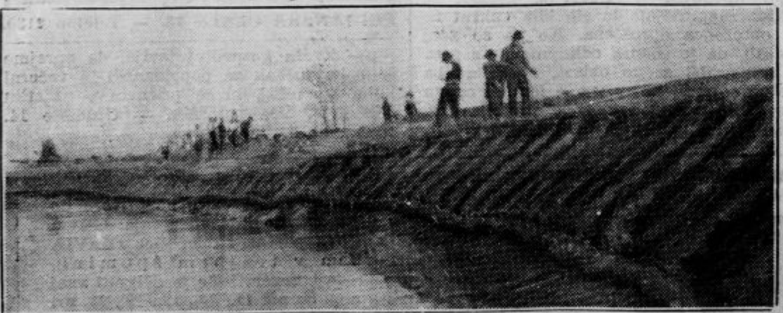
Tako zavarujejo s fašinami nasip in vse obrežje
