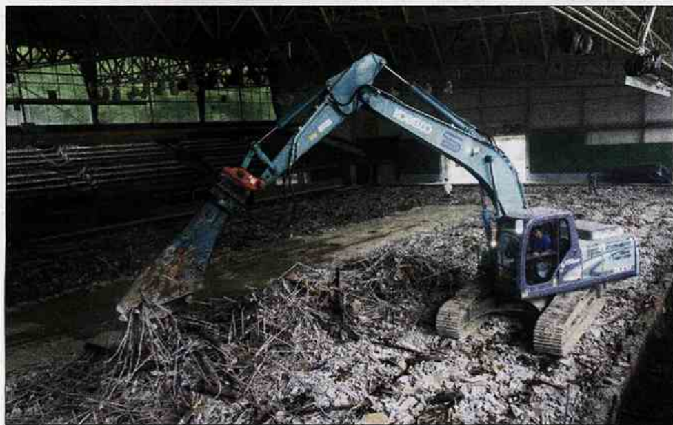
Dotrajana talna plošča je že skoraj odstranjena.
