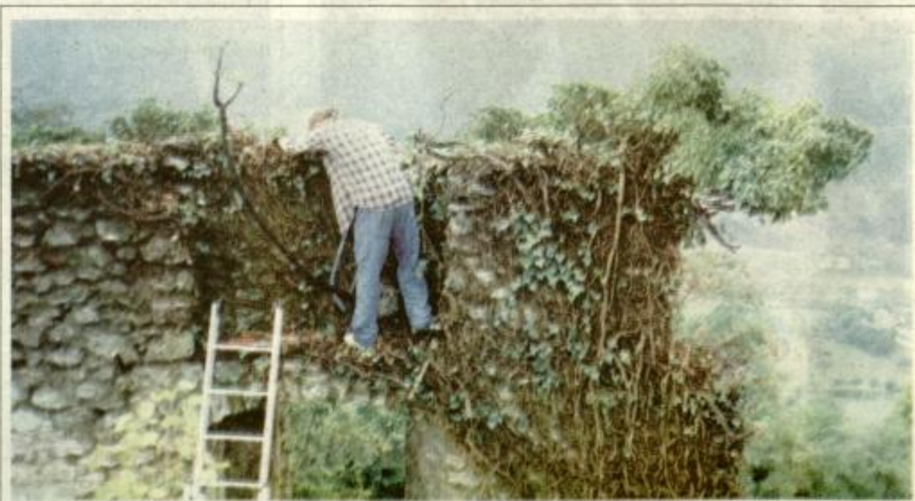
Da obzidja Starega gradu ne bi bila nikoli več takšna! Ure in ure dela je bilo treba za odstranjevanje nešteti kubikov kamena in krušljivega materiala ter grmičevja in pravih dreves, ki so rasla iz obzidja. Posnetek čiščenja vzhodnega obzidja iz avgusta leta 1995.
