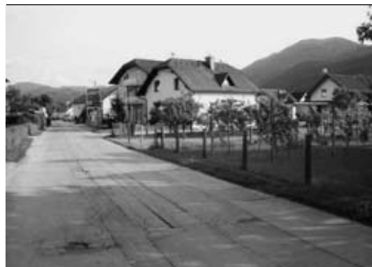
Cesta pred rekonstrukcijo
