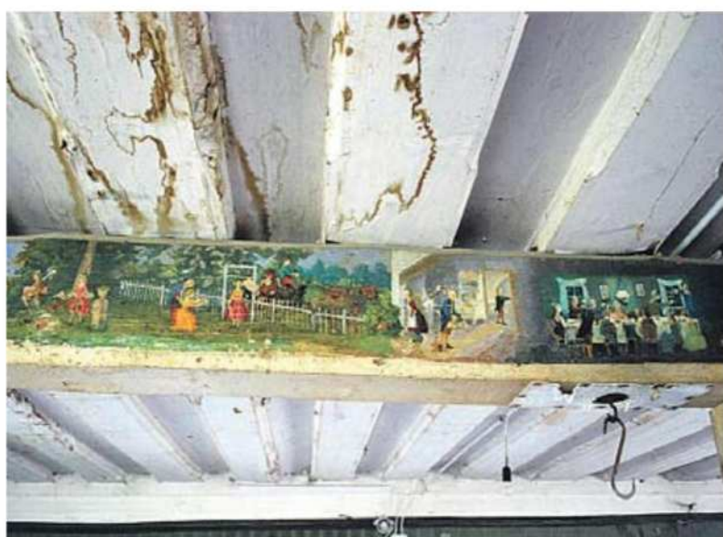
Poslikani tramovi v zgornjem nadstropju zidanice
