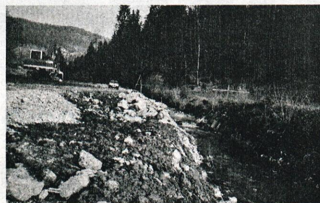
Te dni na obrežju potoka Snovišnica v Tuhinjski dolini brnijo stroji. Podjetja za urejanje hudournikov, ki v okviru programa CRPOV delavcem pomagajo urejati strugo potoka. Ob njem teče cesta proti Snoviku in bodočemu turističnemu kompleksu, ki jo bo treba (okrog 1500 m) še do konca asfaltirati. (fs)
