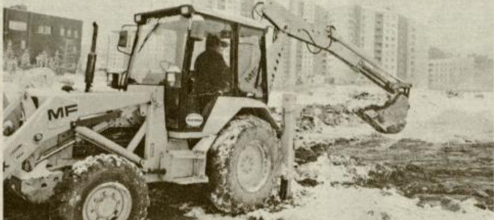
Ob gradnji trgovskega centra tarejo šaleške trgovce številne dileme. A delovni stroji v centru mesta so že zabrnili in kajpada jih ne bo več moč zaustaviti.
