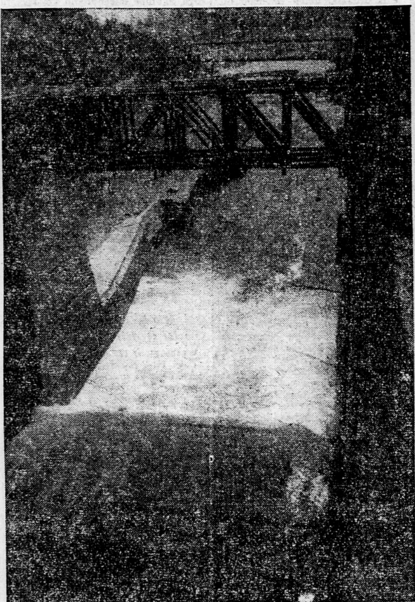
Gradbena dela v desnem pretočnem polju hidrocentrale Medvode so končana in Sava že teče po njem
