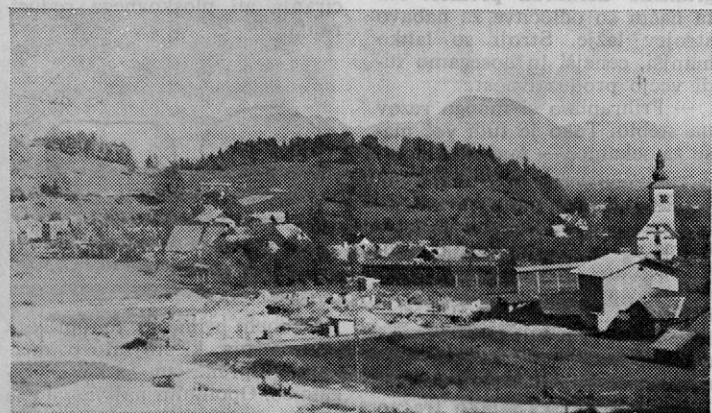
V Spodnjih Gorjah so začeli graditi svoje stanovanjske hiše. Pozna urbanizacija in dovoljenja za gradnjo so marsikomu onemogočila, da bi bila hiša še letos pod streho
