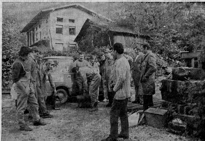
16. 10. je Elmont Bled položil elektroinstalacije
