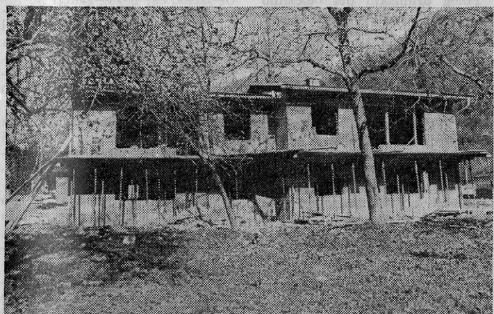
Dvojček bo dobil še strop, stenske obloge in ladijski pod
