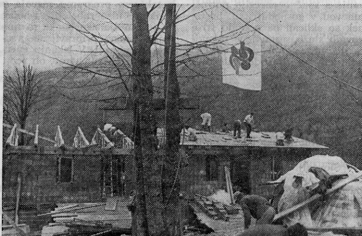
15. 10. so pričeli izdelovati streho
