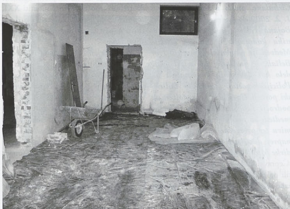
Obnovitvena dela v završkem gasilskem domu so se že začela.
