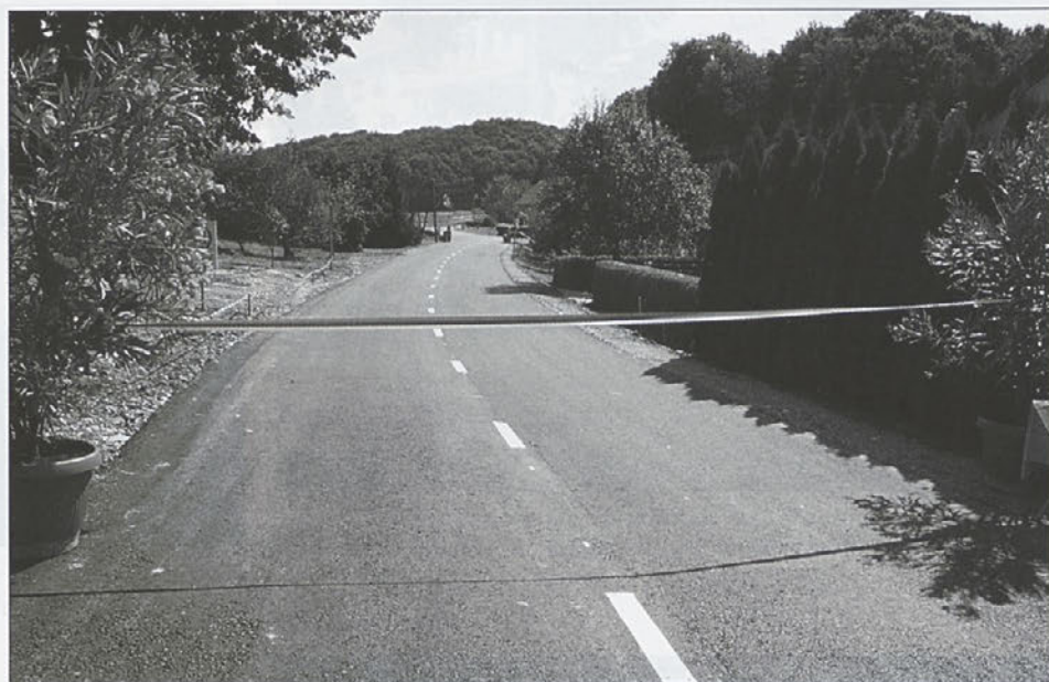
V Goričaku pa je bila slovesnost od odprtju 3,2 kilometra modernizirane ceste od Zavrča do Turškega Vrha, ki je občino veljala okrog 300.000 evrov. Za obe modernizaciji pa so v Zavrču pridobili zelo pomembna sofinancerska sredstva iz Evropskega sklada za regionalni razvoj, prednostne usmeritve Razvoj obmejnih območij s Hrvaško.
