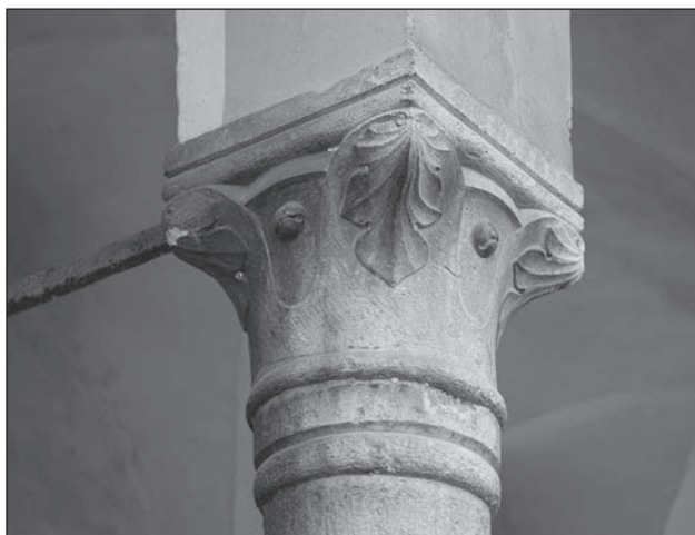
Sl. 30: Koper, nekdanji servitski samostan, zahodno križlo križnega hodnika, kapitel
