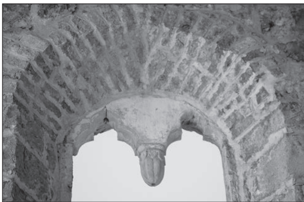
Sl. 12: Bernardin, cerkev sv. Bernardina, severna stena prezbitერიja, vrh okna
