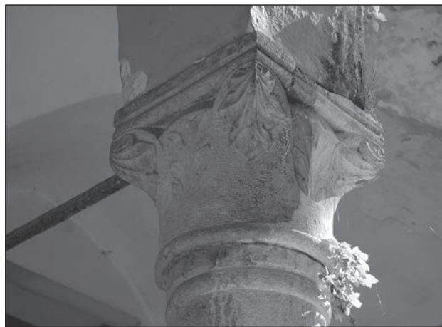
Sl. 32: Koper, nekdanji servitski samostan, zahodno križlo križnega hodnika, kapitel
