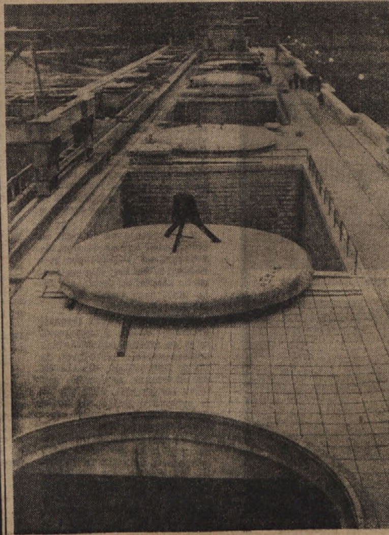
Del naprav hidrocentrale na mariborskem otoku
