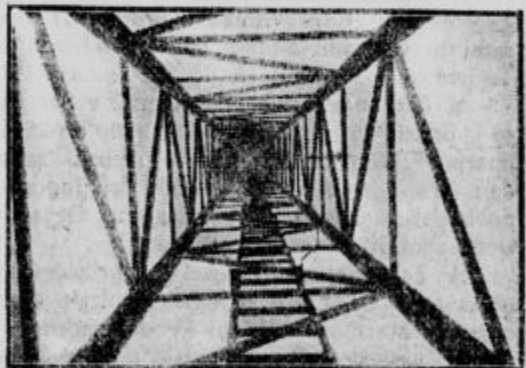
Antenski drog, slikan v notranjosti od tal proti vrhu. Ob strani vodi do vrha kontrolna lestva.
