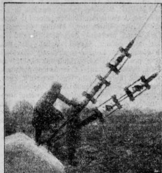
Isolatorji na pritrdilnih žicah.
