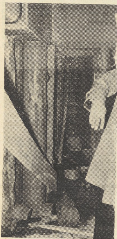
Belilnico v tovarni viskoze v Banjaluki je bilo zelo težko popravljati. Delo se je odvijalo v ozkih prostorih in v stalni nevarnosti, da se kaj ne poruši
