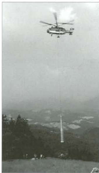
Helikopterska montaža žičničarskih stebrov na smučišču Kaštivnik na Kopah
