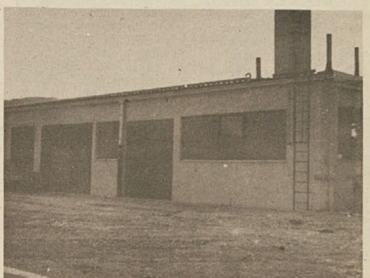
V letu 1986 je investitor KK Šentjur tozda Klavnica zgradil tudi novi energetski objekt v sklopu nove kotlovnice. Energetski objekt zajema prostore za agregat 240 KW, kompresorsko postajo in trafo postajo. Del je prav tako izvajal Ingrad GOŠentjur.
