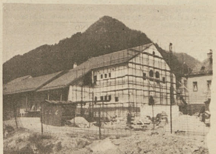
Izvajalec del Ingrad je že pričel z zaključnimi deli v notranjosti in na fasadi (Demit).
