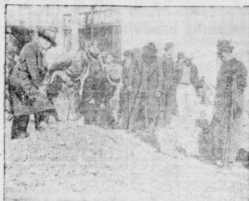
V Nantesu na Francoskem se je pokvaril plinovod in plin je uhajal v hiše, kjer je podleglo zastrupljenju več oseb. Oblasti so odredile preiskavo. Na sliki: inženjerji in delavci na terenu
