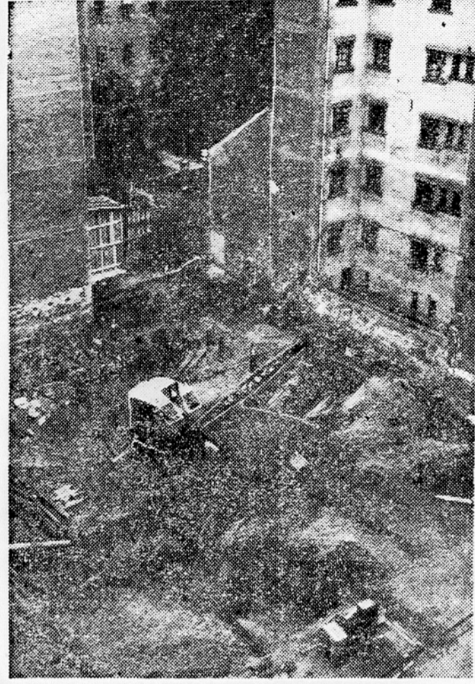
Med drugim vzbujajo zanimanje Ljubljancem gradbišče agencije za izvoz in uvoz (Slovenija-impex) na vogalu Kidričeve in Beethovne ulice. Devetnadstropna, izrazito poslovna stavba — ozka parcela ne dopušča gradnje stanovanj — bo po sedanjih računih sodeč pripravljena za vselitev konec prihodnjega leta. Tloris stavbe ima obliko približnega kvadrata v izmeri 25 m. Posebnost bodo hladilne in ogrevalne naprave, na katerih se bodo lahko učili še drugi za znanje, pa tudi neznani graditelji sodobnih stavb v bližnji prihodnosti.
