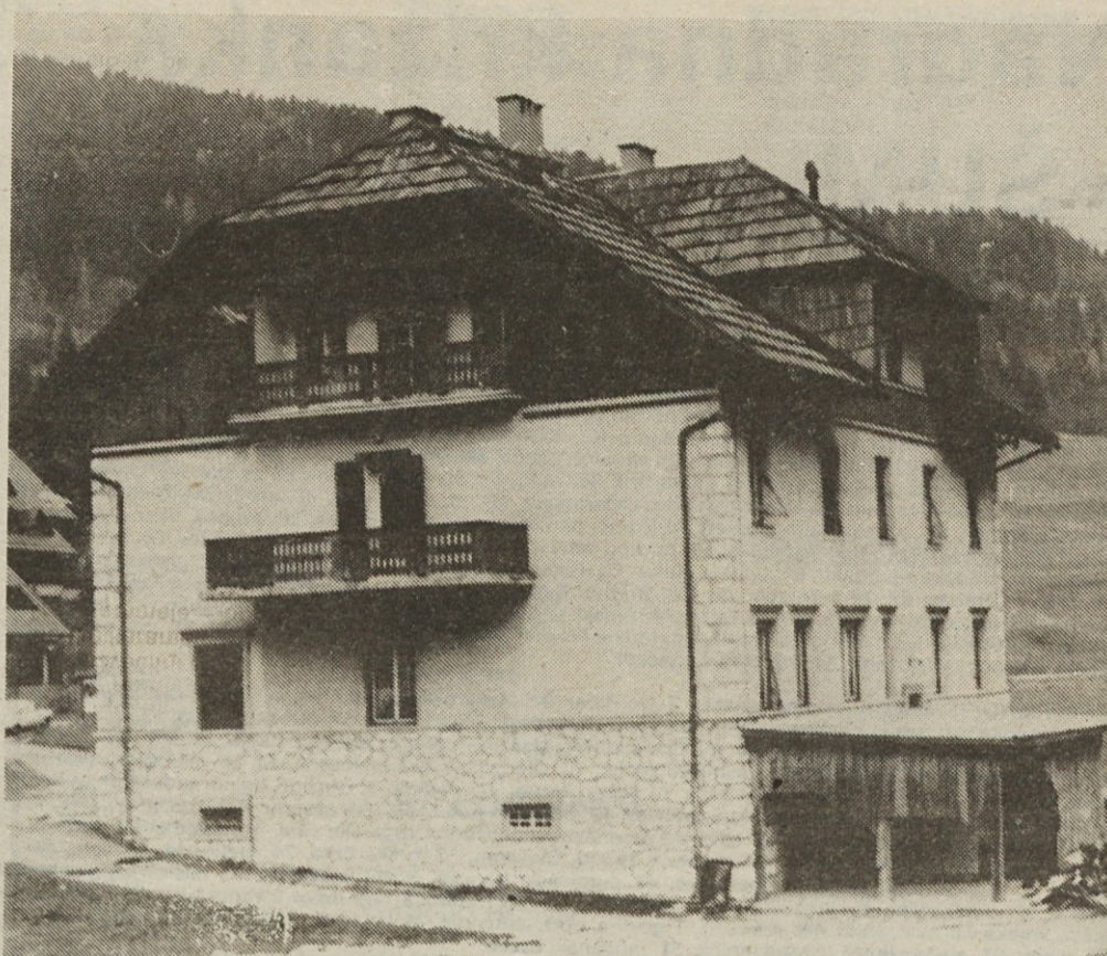
Na Jezerskem: v kleti te stavbe je pekarna s pečo na drva, ki bo kmečki kruh začela peči takoj po novem letu.
