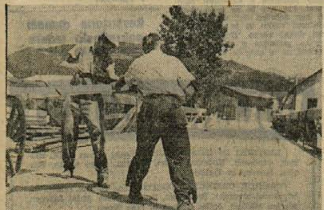
Na sevniskem mostu čez Savo te dni pridno zamenjujejo pod. Vseposod, kjer so deske že trhle, bodo položili nove, da bo promet spet varen.
