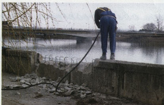
Pripravljala dela za pešmost so pričeli delavci SCT.
