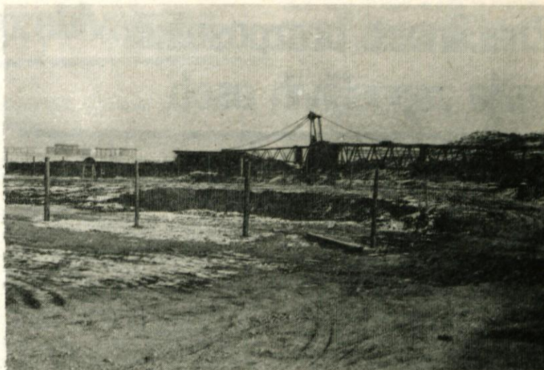
Gradbena dela za nove objekte delovne organizacije TRAK v Mengšu so se že pričela
