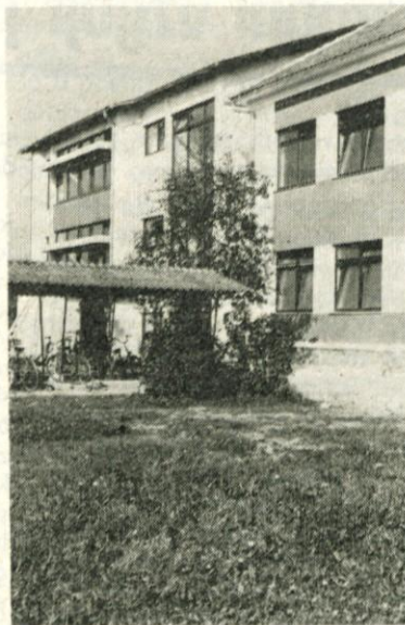
Prenovljen in novozgrajen del Osnovne šole v Dobu
