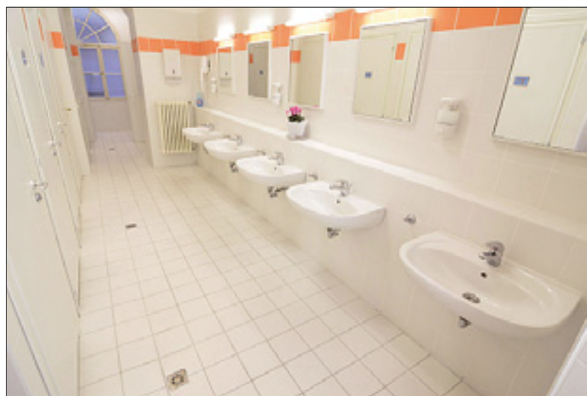
Sanitarije so bile zaradi intenzivne rabe potrebne prenove
