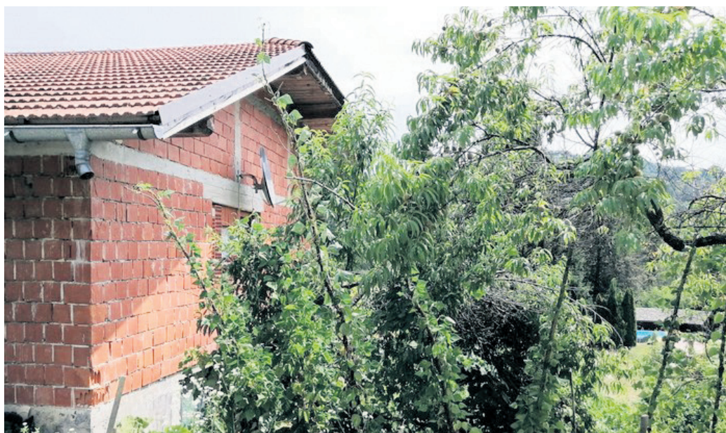
V hišo brez fasade močno pronica vlaga, streha je na nekaterih delih odkrita. (Foto: RKS - OZ Žalec)
