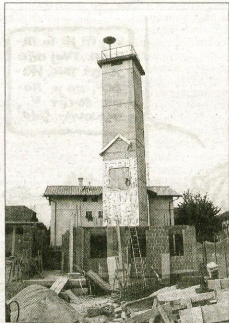
Na Primskovem potekajo pripravljala dela za betoniranje druge plošče.
