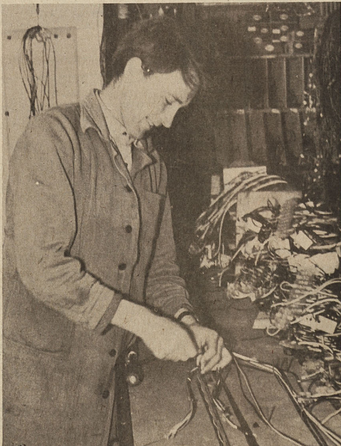
Delavec Silvo Rugelj sestavlja elektrotrake, ki jih bodo vstavili v dostavna vozila.
