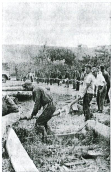
Polaganje kabla za novo žago
