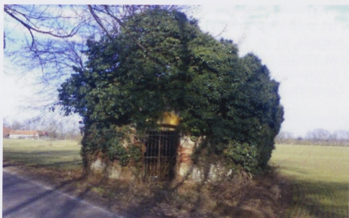
Razpadajoča grajska kapela, danes (zasebni arhiv).
