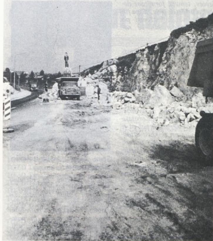
Novi cestni priključek za IMV v gradnji
