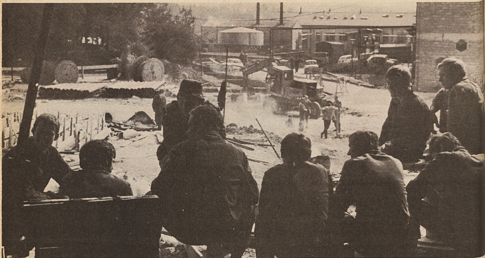
Naši med dopoldanskim odmorom na gradbišču
