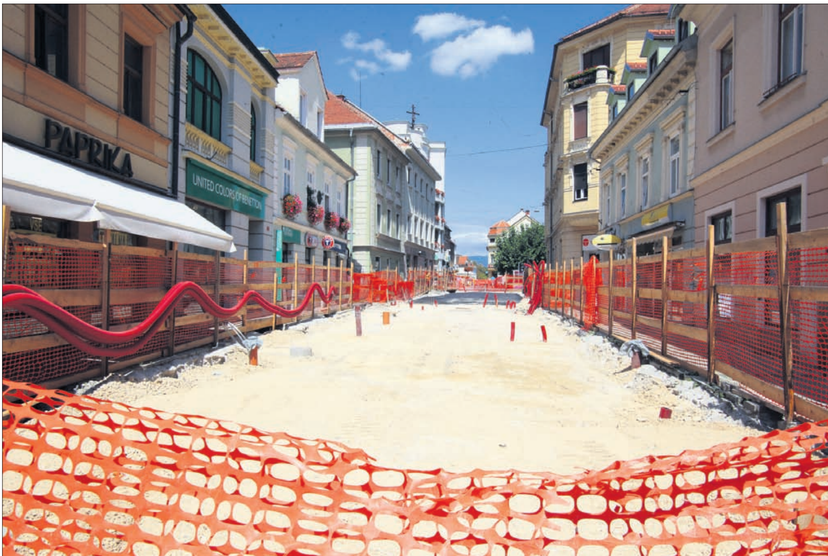
Gradbišče brez CMC-jevih delavcev
